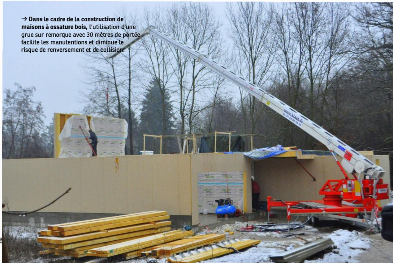
→ Dans le cadre de la construction de maisons à ossature bois, l'utilisation d'une grue sur remorque avec 30 mètres de portée facilite les manutentions et diminue le risque de renversement et de collision.
